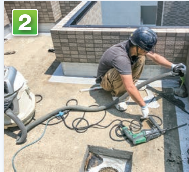
2 防水層内の水の吸引
