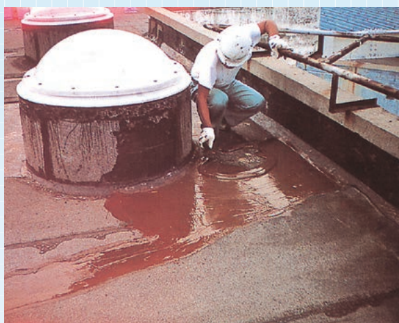
② 下地調整 ナルファルトA 塗布+モルタル
