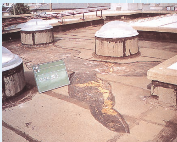
① 下地処理 旧防水層の部分撤去
