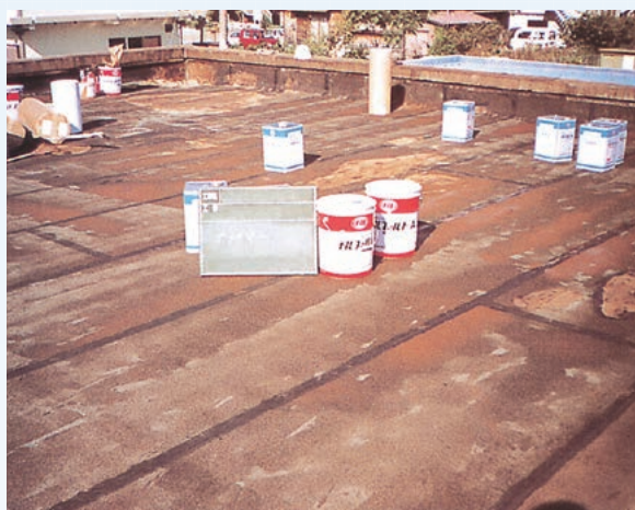
③ プライマー塗布 ナルファルトプライマー
